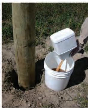
Pour Part B container into Part A container.
